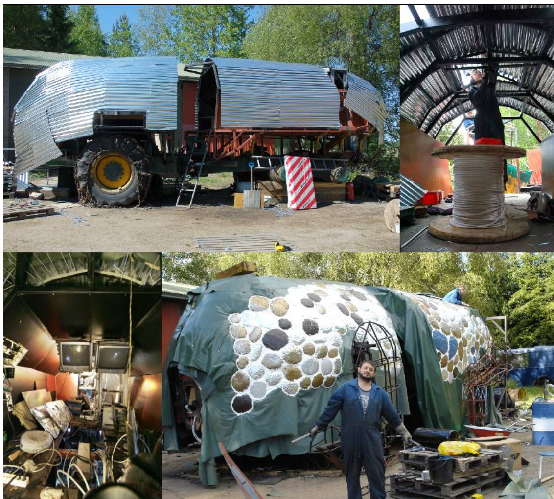
KUVIO 40. Lohikäärmeen aaltopeltirakenne, sisustan vanerit ja aaltopellin päälle tuleva peite, johon liimataan suomet. Kuvassa espanjalainen lohikäärmeapula David Segura.
